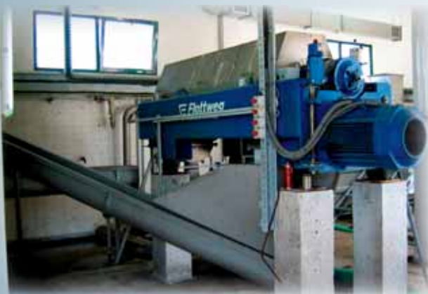
↑ Εικόνα 6: ΚΕΛ Λάρισας. Παράδειγμα μηχανισμού αφυδάτωσης ιλύος. [Φωτ.: Αργ. Παπακωνσταντίνου]
