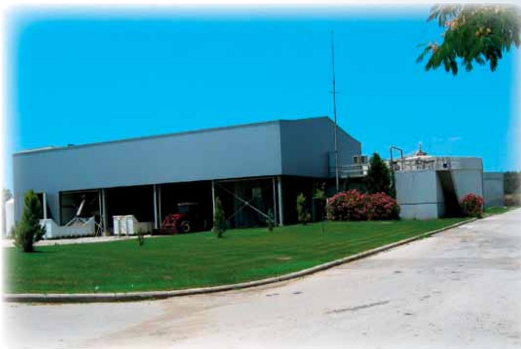
← Εικόνα 1: ΚΕΛ Λάρισας. Άποψη κτιρίου, στο εσωτερικό του οποίου πραγματοποιούνται δραστηριότητες μηχανικής προεπεξεργασίας των αστικών λυμάτων [απολίπωση, εξάμμωση, εσχάρωση κλπ.]. Εξωτερικά διακρίνονται οι σωλήνες συγκέντρωσης των παραπάνω υλικών στα ειδικά δοχεία.
